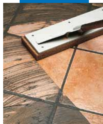
Čištění jedenkrát pálené dlažby houbovým hladítkem
