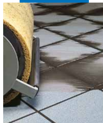
Strojní dokončování povrchu dlažby
