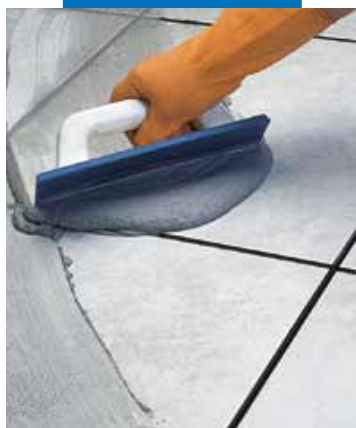
Spárování keramické dlažby gumovou stěrkou
