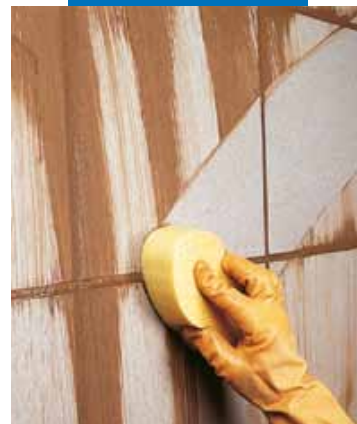
Dokončení povrchu obkladu houbou
