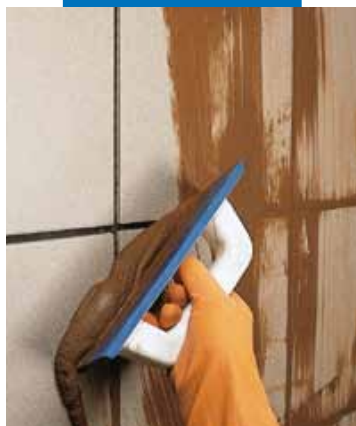
Spárování obkladu v exteriéru gumovou stěrkou
