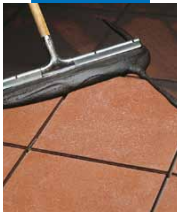
Spárování dlažby z terakoty gumovým hladítkem
