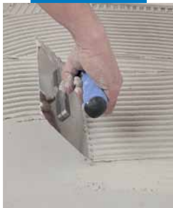
Nanášení Keraflexu Extra S1 zubovou stěrkou
