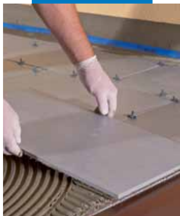
Pokládka keramické dlažby
