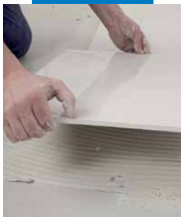
Pokládka keramické dlažby
